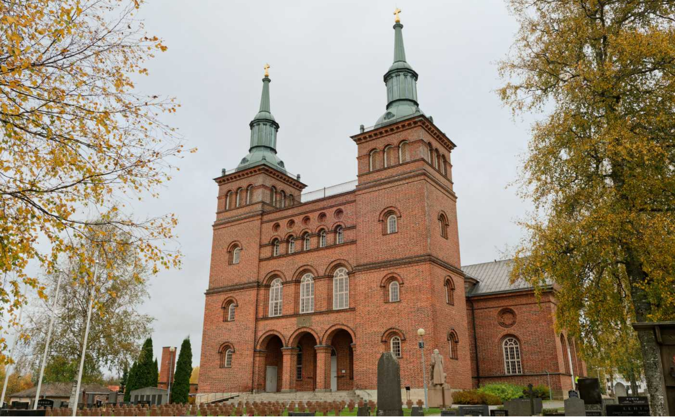
Tyrvään kirkko Rakennushistoriaselvitys 31.10.2025
