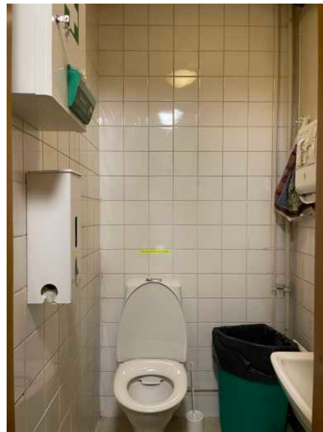
Sakastin wc-tila, johon käydään eteistilasta.
