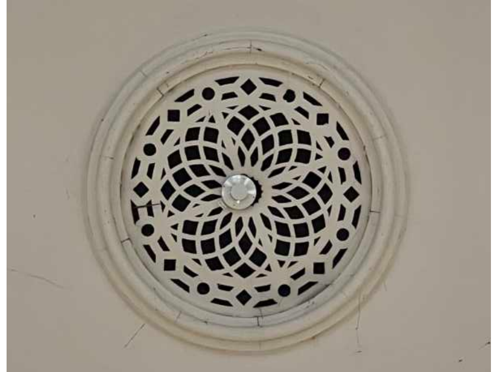
Ristivarsien holvien katossa olevat aukot ja niiden keskelle vuonna 1982 lisätyt palonilmaisimet.
