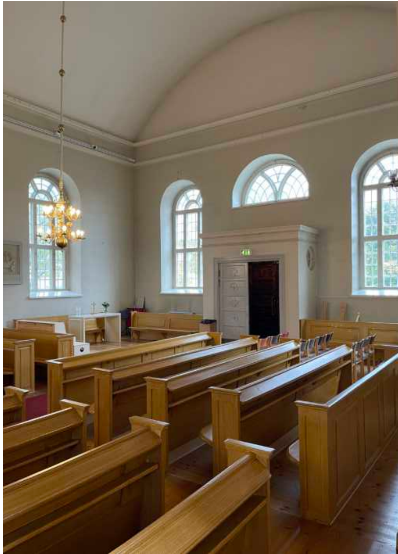
Ristivarsien tuulikaapit ja heiluriovet madallettiin vuonna 1982. Ovet, karmit sekä karmilistat säilytettiin, ne ovat vuodelta 1938.
