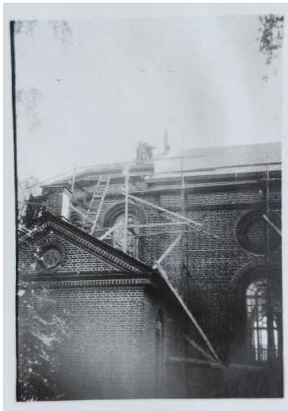
Valokuva kirkon tiilikatteen rakentamisesta. Sastamalan seurakunnan arkisto, kuvaaja tuntematon.
