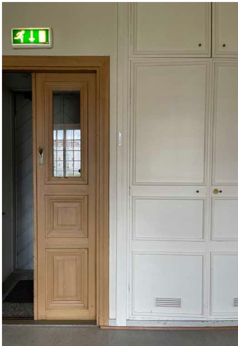
Toimitushuoneen eteinen/tuulikaappi sekä vuonna 1938 rakennetut ja vuonna 1981 vanhan mallin mukaan korjatut kiintokaapit.
