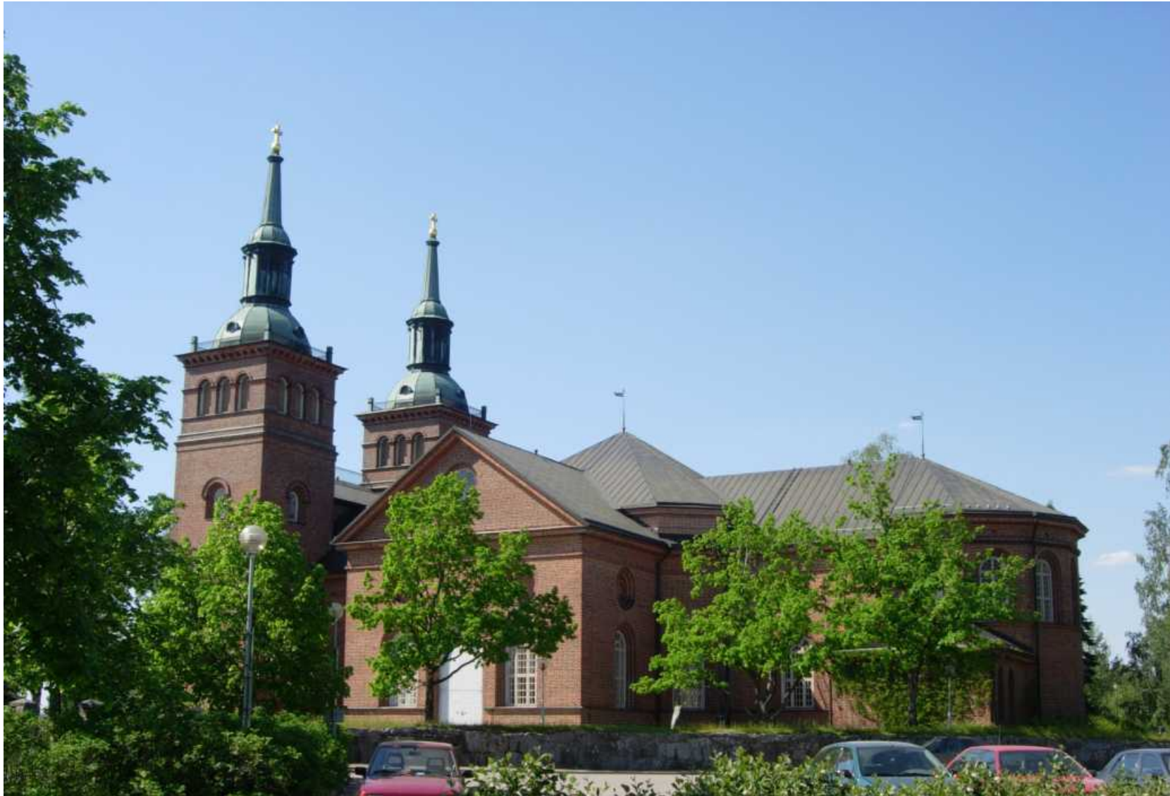
Valokuva Kirkkokadun ja Puistokadun risteyksestä. Kirkon tornit katettiin kuparilevyillä vuonna 1954. Kirkon vanha tuohi- ja paanukate poistettiin ja korvattiin konesaumatuilla pellillä vuonna 1995. Valokuva: Samuli Lintula - Own work, CC BY 3.0, https://commons.wikimedia.org/w/index.php?curid=4641904 .
