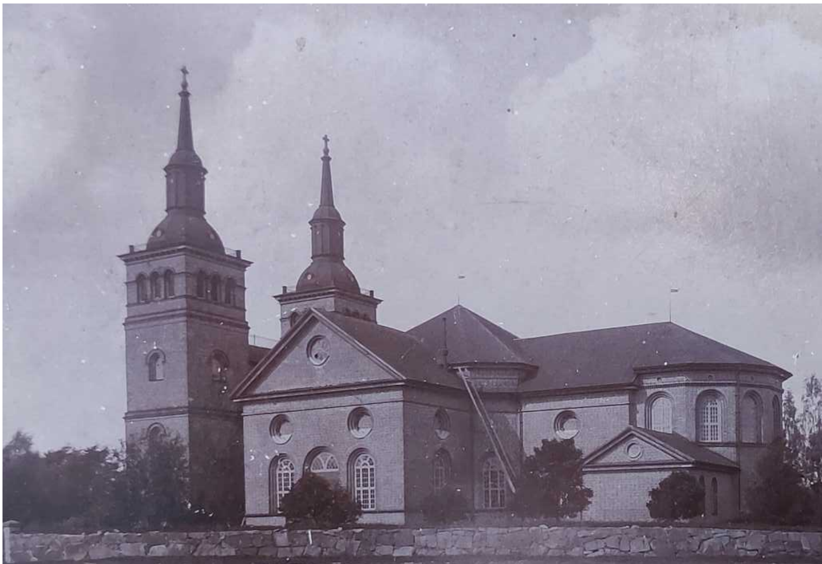
Valokuva Kaakosta. Kuvassa näkyy kirkon vesikaton vanha paanukate. Kirkon tornit olivat ruskeaksi maalattua rautapeltiä. (Sastamalan seurakunnan arkisto, kuvaaja tuntematon)
