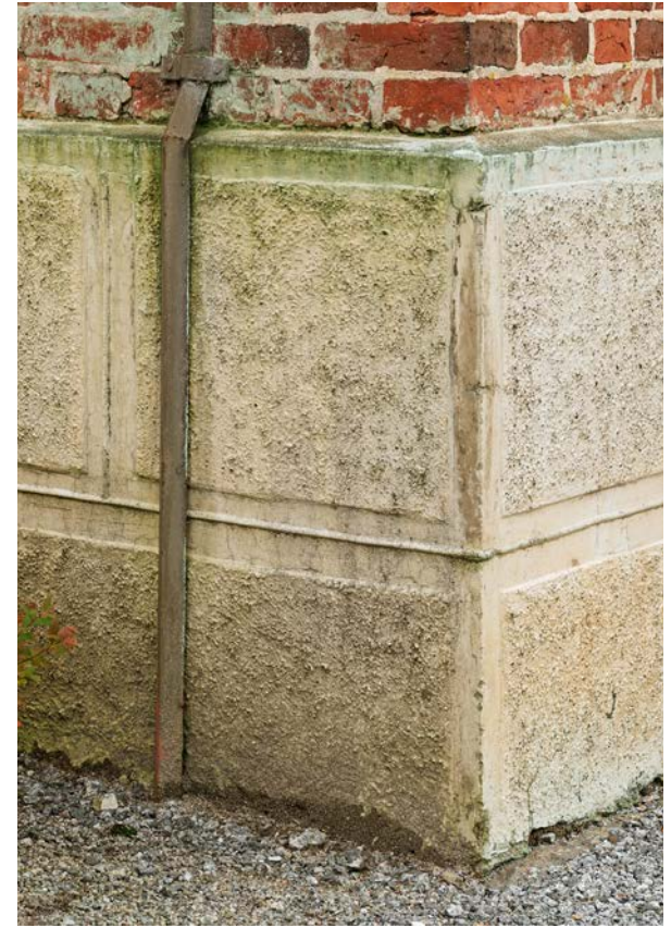
Luonnonkivisokkeleiden päällä oleva rappauspinta paikkakorjataan.
