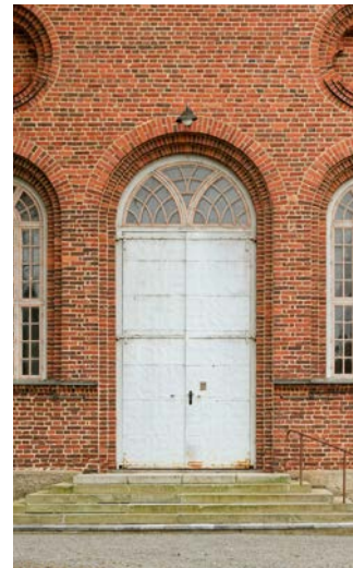
Pohjoiseen sivusakaraan johtava ovi Oven takana sisempi ulko-ovi
