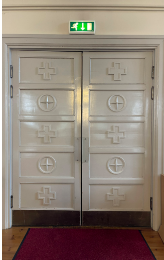
Pääsisäänkäynnin tuulikaappin ovi
