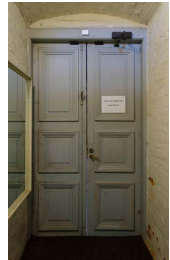
Pellitetyt ulko-ovet ovat puisia sisäpinnoiltaan, kuvassa pohjoiseen torniin johtava ovi
