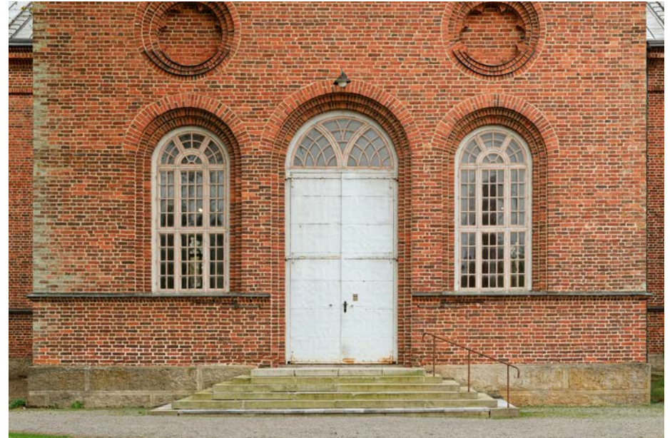
Pohjoisen sivusakaran sisäänkäynnin portaan toiselle puolelle rakennetaan kaide.
