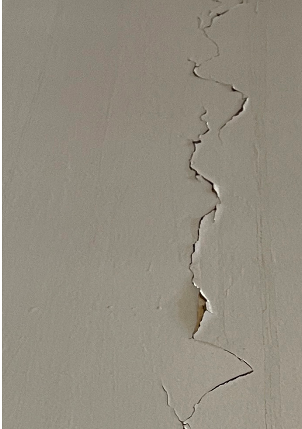
Kaikkien sisäpintojen rappauksen halkeamat, kohoumat yms. paikkakorjataan, -verkotetaan ja -maalataan.
