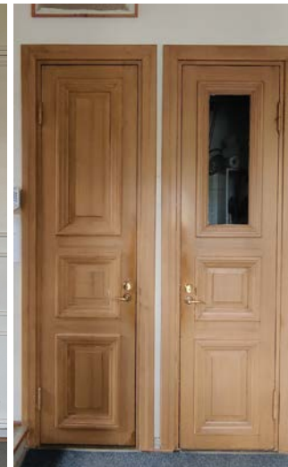
Sakastin ootratut ovet (tekninen tila ja siivoushuone)
