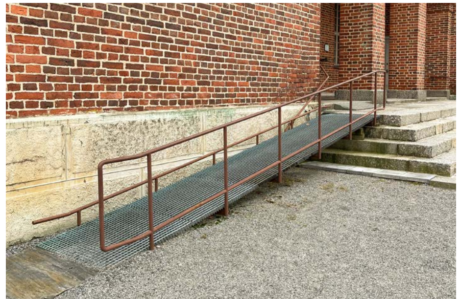
Pääsisäänkäynnin luiska uusitaan ja se tehdään kivrakenteisena.
