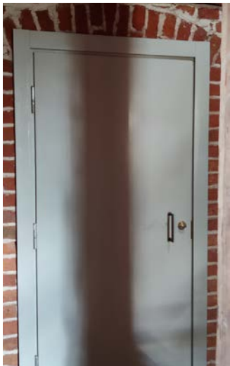
Palo-ovi eteläisestä tornista ullakotilaan
