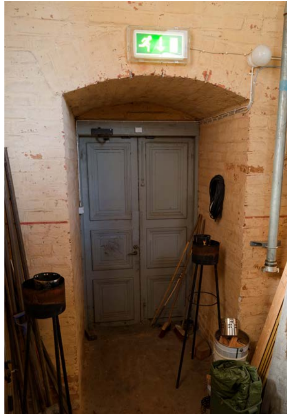
Tornien sisäänkäynneille tehdään uudet pariovet.
