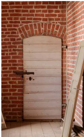
Ylemmän galleriakäytävän väliovet tornihuoneisiin
