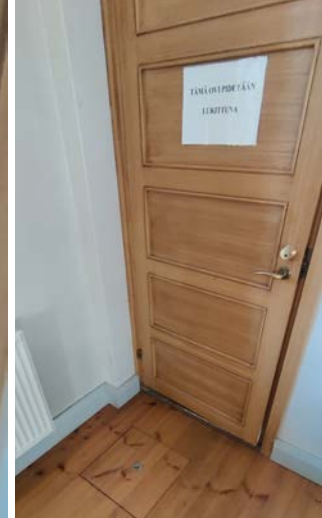
Vibkiparien odotustilasta kirkkosaliin johtava palo-ovi (kirkkosalin puoli)
