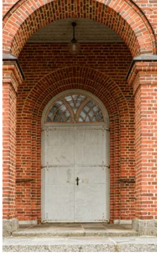
Pääsisäänkäynnin ovi Oven takana sisempi ulko-ovi
