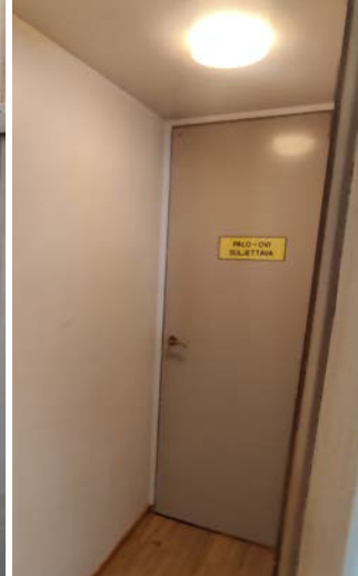
Vibkiparien odotustilasta kirkkosaliin johtava palo-ovi
