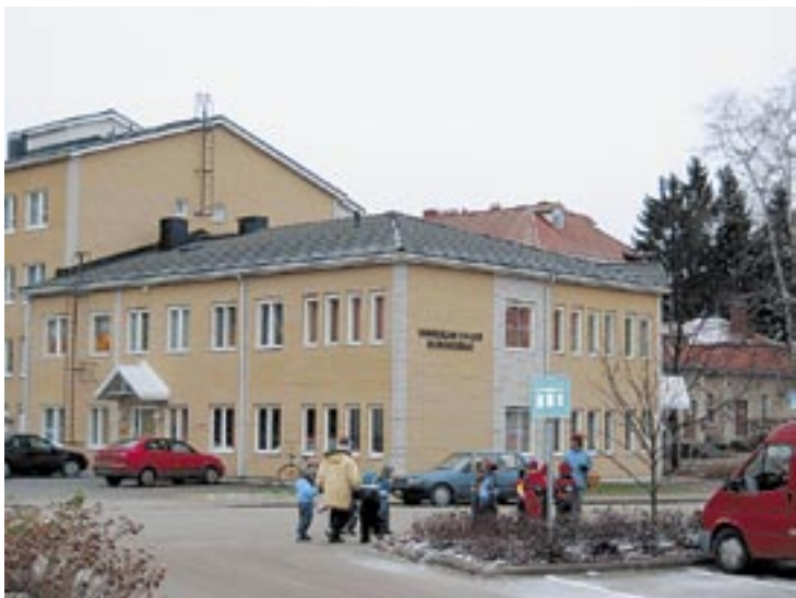
Seurakunnan virastotalo Aittalahdenkadun ja Marttilankadun kulmassa on valmistunut 1990.
