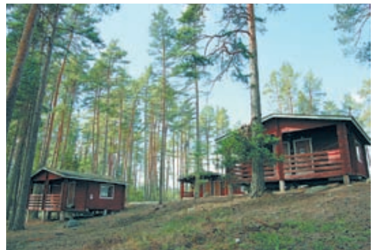
Leirimajalla on jo valmistauduttu alkaviin rakennustöihin kaatamalla tontilta puita. Vanhat mökit siirtyvät syksyllä Kiimajärvelle Äetsän seurakuntayhtymän leiripaikkaan.
